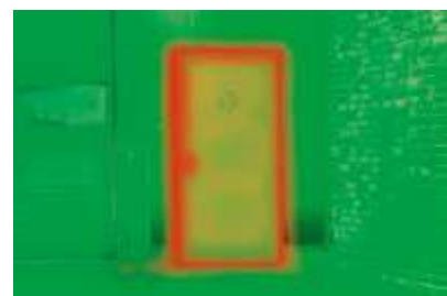
Sichtbarer Energieverlust ohne thermisch getrennte Tür
